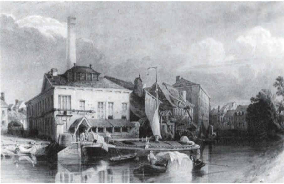
De gasfabriek aan de Grote Huidevettershoek.
