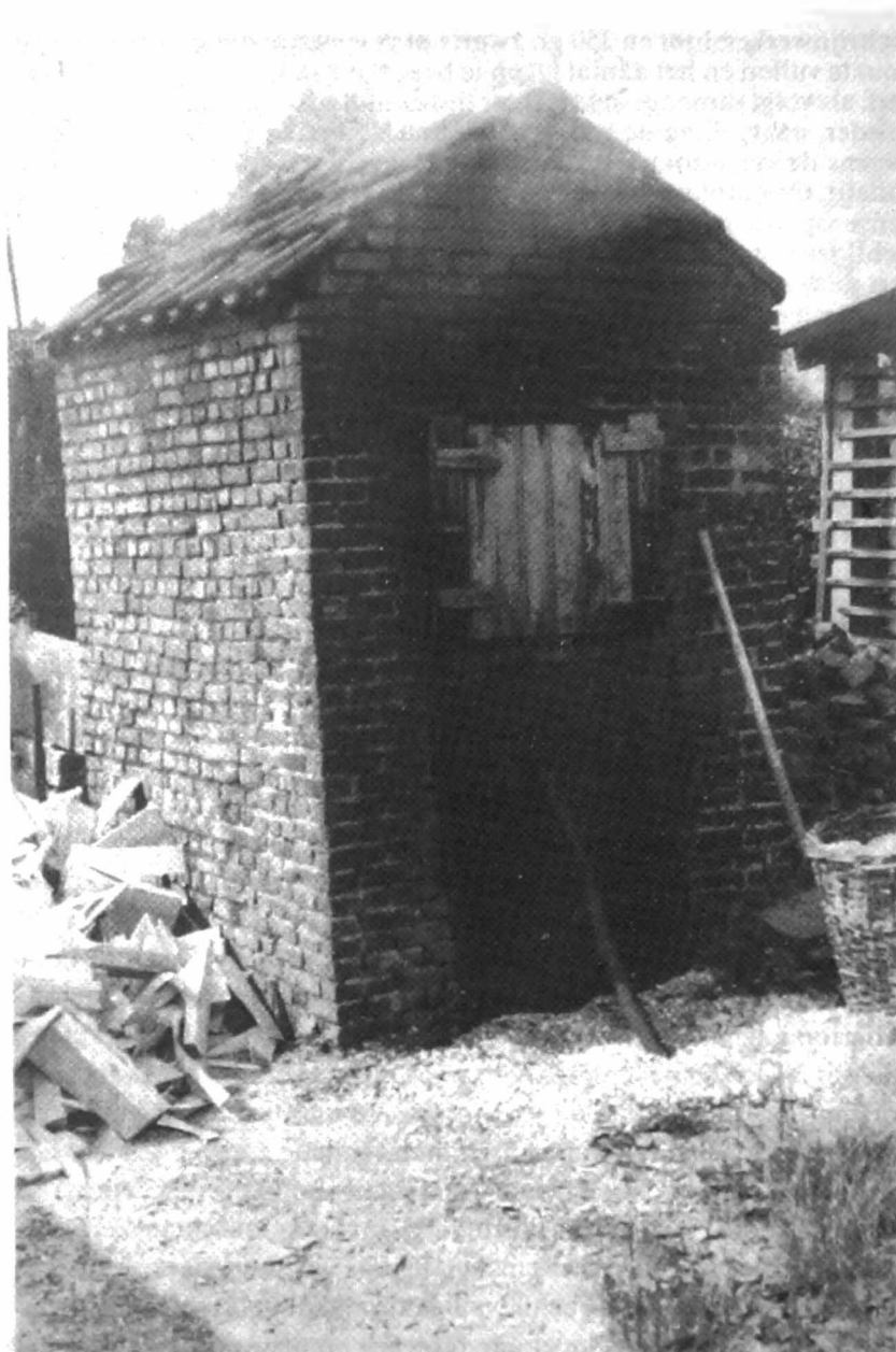
Afb. 5: Het rookkot van de gebroeders Luycx te St.-Gillis-Waas (naar P. Hesters)
