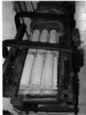
Perspaard voor productie en snijden van drie draneerbuisen.
