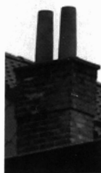
Twee hoge schouwbuizen op de achterkant van de woning Burgemeester Bertenplein 25 te Poperinge, aan de overkant van de pottenbakkerij Dupont. Rood aardewerk, zonder geprofileerde bovenrand.
