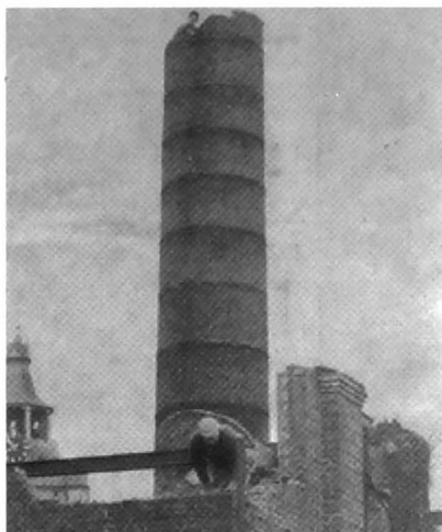
Afbraak van schouw en fabrieksgebouw in 1998.
