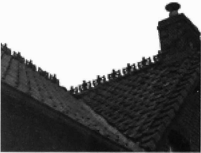
Dakveursten met nokversiering op een woning in de Koestraat te Poperinge.
