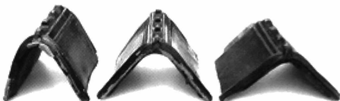
Dit type nokpan werd op het houten nokpanpaard geplooid volgens de scherpte van het dak en volgens het soort dak. Van links naar rechts: voor een schaliedak, dak van platte dakpannen en dak van gegolfde dakpannen.
