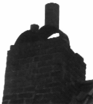
Schouwveursten Ver Elst-Dupont in de Veurnestraat te Poperinge op 1 februari 2006. Naast het gewoon exemplaar staat rechts een extra groot exemplaar met een stuk draineerbuis van grote diameter.
