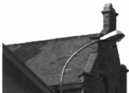
Dak met schalieveursten, Ieperstraat 145, Poperinge op 12 maart 2006.
