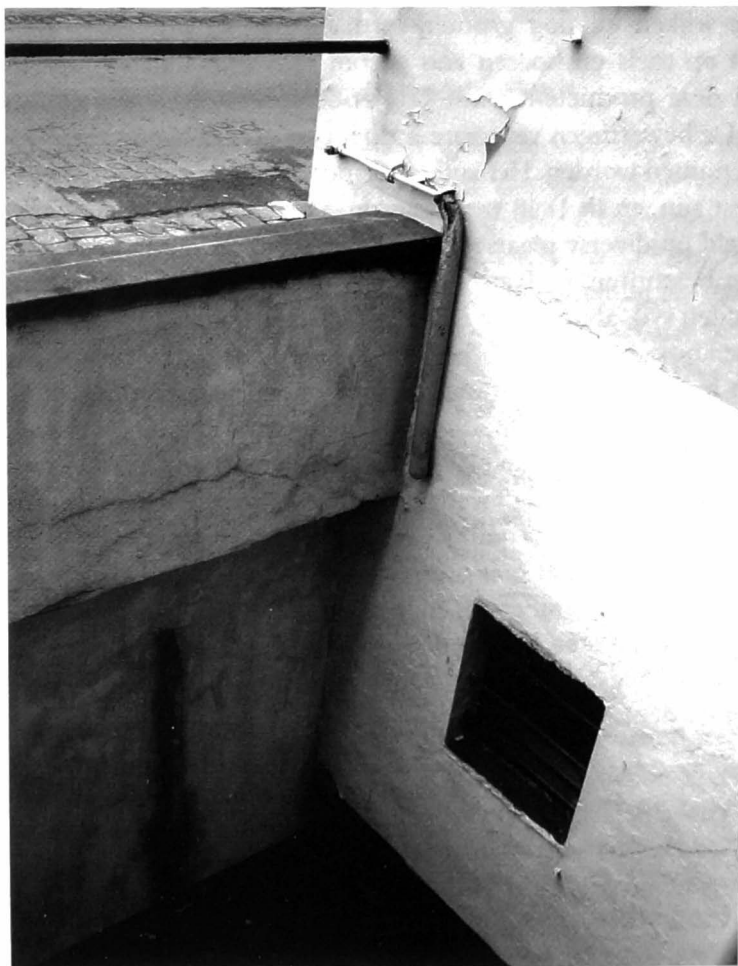
Afb. 2: Het enige anno 2004 nog zichtbare overblijfsel van de Karnemelkbrug aan de Steendam (foto C. Puttevils) te situeren op afb. 5 net rechts van het naamonderdeel '-brug'. De functie van het zware muuranker is niet duidelijk. Wellicht is het onderdeel van een brugpijler.
