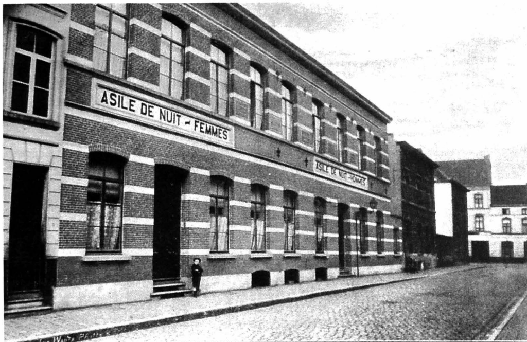
Afb. 1. Het gebouw in de Tinkstraat.
