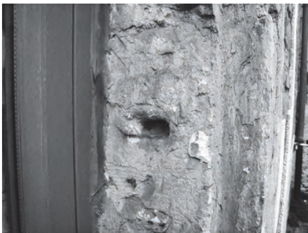
Afb. 22. Holte ('doorkgat') aan de zijkant van de vensteropening naast de deur aan de Goudstraat 12. Hierin werd de steun geplaatst voor het bovenluik in geopende toestand (foto's 2010).
