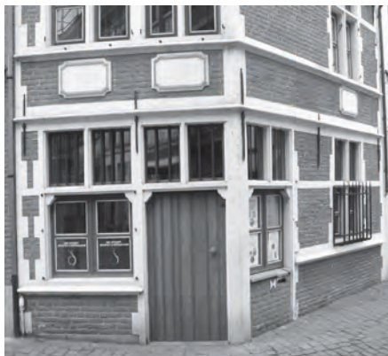
Afb.3. Gewad 31 (foto 2010). Dit geveltje uit 1704 geeft de in dit artikel beschreven (hoek)winkeltypologie perfect weer: forse hoekkolom, in de muuropvulling onderaan is naast de hoekzuil nog een tweede (gewezen) deuropening herkenbaar; gelijkvloerse winkelvensters met één onderlicht en twee bovenlichten (drielichtvensters). Verderop in de Abrahamstraat een kruisvenster dat niet bij de winkel hoorde; op de verdieping - uiteraard - eveneens kruisvensters (vierlichten).
