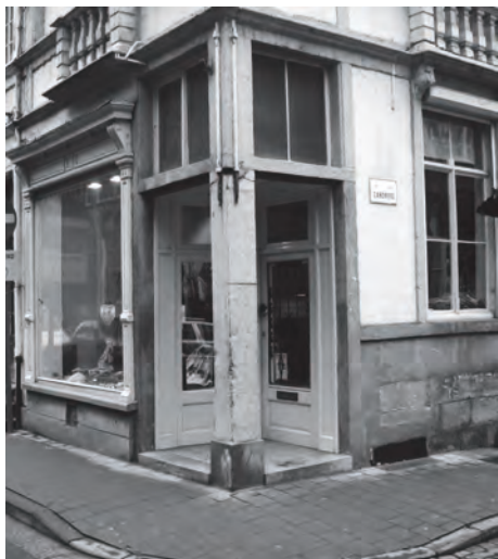
Afb. 7. Hoogpoort 85, hoek Zandberg (foto 2015): open portiek van hoekwinkel in een huis van latere datum (eind 18de eeuw).
