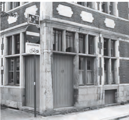
Afb. 6. Goudstraat 12 (foto 2010). Massieve hoekzuil uit blauwe hardsteen geflankeerd door twee nu vastgemaakte deuren. Wellicht vroeger open. De twee winkelvensters ('drielichten') geven samen met de deuren de afmetingen aan van de winkel van kruiddennier Pieter Moreau, bouwer van dit huis uit 1707.
