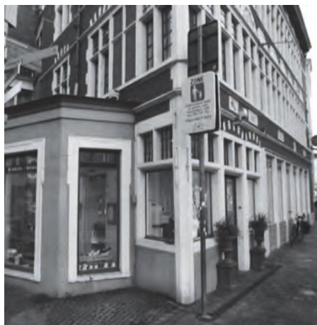
Afb. 10. Typische 'drieliicht' winkelvensters naast de hoekzuil en de ingangdeur van dit huis aan de Kleine Vismarkt-hoek Kraanlei (foto 2015).
