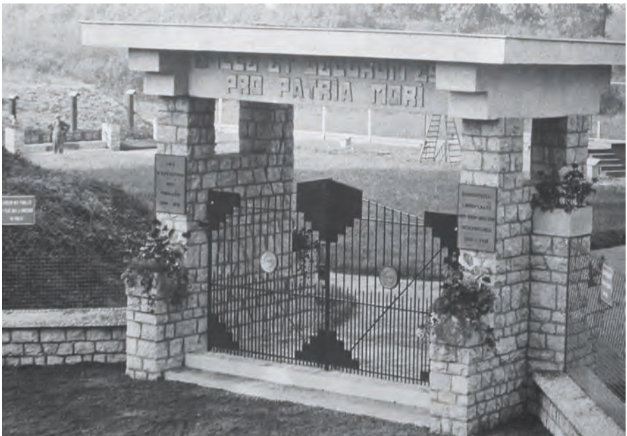
Afb. 10. Betonnen luifel boven de ingangspoort van het 'Oord der Gefusilleerden' aan de Offerlaan met de spreuk van Horatius (foto SCMS 3841 in het Gentse stadsarchief).
