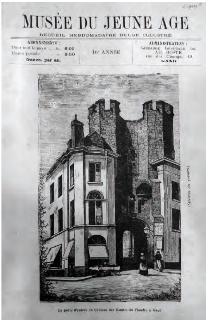
Afb. 2. Het nog te restaureren poortgebouw met aanbouw (uit een museumjournaal van 1890).
