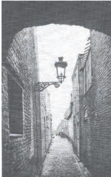
De toegang tot het Ambachtstraatje vanuit de Ooststraat, circa 1910. (De verworpenen van Veurne)
