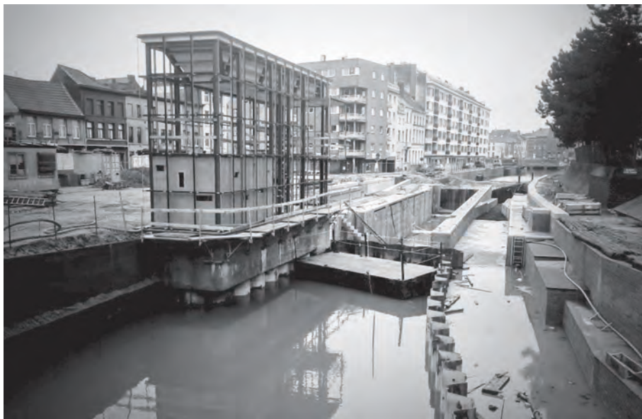
Afb. 2. Anno 2012 Scaldissluis in aanbouw.
