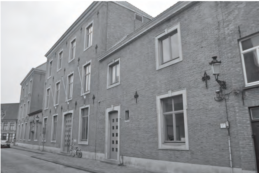
Huidige complex in de Sint-Clarastraat te Brugge. Foto MOERAERT H., 2017
