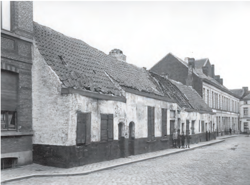
Werkmanshuizen in de Kazernestraat voor de afbraak, foto 1917. Collectie G. DESMET
