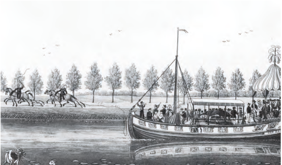
De "barge" op de Brugsevaart.
