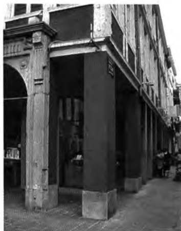
Afb. 8. Langemunt nr. 2, hoek-Hoogpoort (foto 2010). Massieve hoekzuil. De deuromlijsting er naast in de Langemunt werd pas enkele jaren geleden uit het Sint-Baafs steenmuseum overgebracht bij de restauratie van dit huis uit 1715 waarvan het gelijkvloers voordien volledig gewijzigd was. Een dergelijke deuromlijsting is niet typisch voor winkels.
