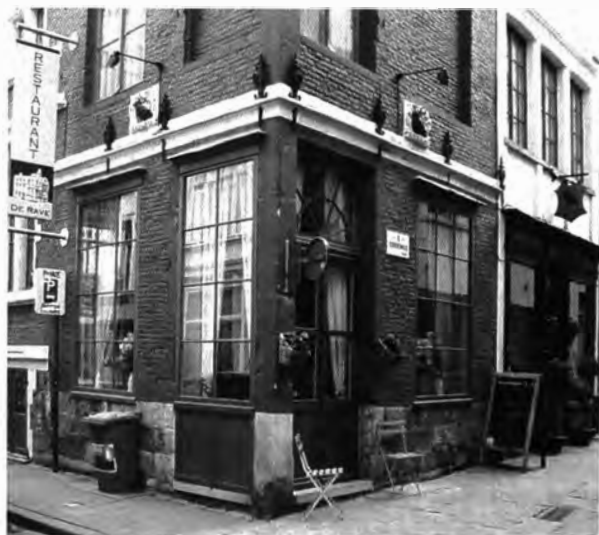
Afb. 16, 17 en 18. Huis De Raeve met bijgevoegd buurhuis in de Schepenhuisstraat, samen nr. 2 (foto 2010 vergeleken met toestand vóór de restauratie, foto uit Bouwen door de eeuwen heen, Gent deel 4na , 1976 en een schets van Armand Heins in de Inventaire archéologique nr. 485, april 1900). Schoolvoorbeeld van zachte restauratie met maximaal behoud van bestaande elementen, tot en met de raamindelingen. Deze van het winkelgedeelte zijn niet terug te voeren tot de oorspronkelijke 17de- of 18de-eeuwse toestand. Ze vertegenwoordigen een waardevolle, zelfs zeldzaam geworden getuigenis van een latere winkelramenstijl. De vensters van de 'voute' behielden hun originele kruisen met aan de eerste verdieping 'dievenijzers' in de bovenlichten.
