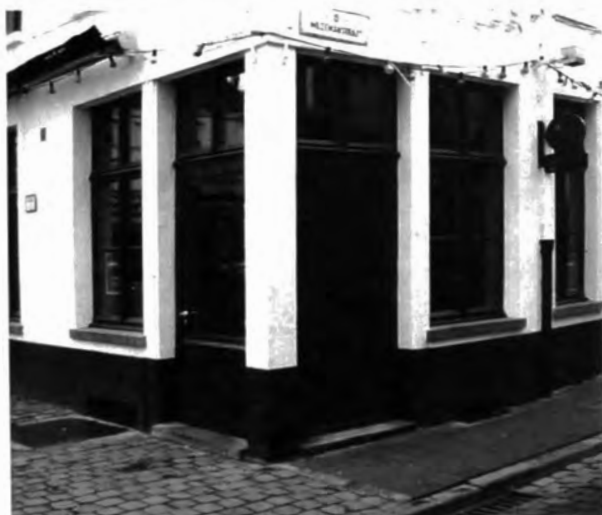
Afb. 14 en 15. Wijzemanstraat 10 en 13, hoek varmend met Bij Sint-Jacobs (foto's 2010). Hoekdeuren in al of niet open partieken in wellicht meermaals oppervlakkig veranderde geveltjes. Moeiteloos terug te voeren naar de situatie te zien aan de huizen Gewad 31 en Goudstraat 12.
