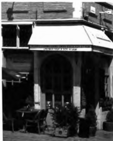
Afb. 12. Kraanlei nr. 1 (foto 2015). De gerestaureerde benedenvensters van dit hoekhuis herinneren aan de bij restauraties in het begin van vorige eeuw zeer geliefde pittoreske kleine houten raamlindingen, eerder dan aan de vermoedelijke originele toestand.
