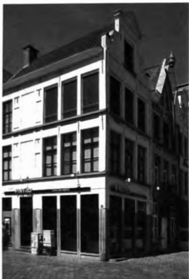
Afb. 11. De hard gerestaureerde gevels van het hoekhuis 'Den Buck' Vrijdagmarkt 1, hoek vormend met het Grootkanonplein geven nog een impressie van hoe de vroegere winkeltoestand moet geweest zijn bij de bouw in 1718 (foto 2015).
