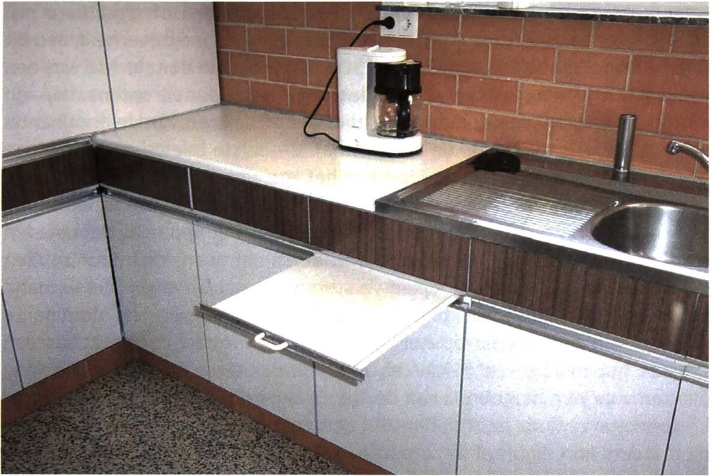
Figuur 9: Uitschuifplankje om zittend te werken in de keuken van een voorbeeldwoning van de Boerinnenbond uit 1959 te Kessel-Lo (© Els De Vos, 2003)
