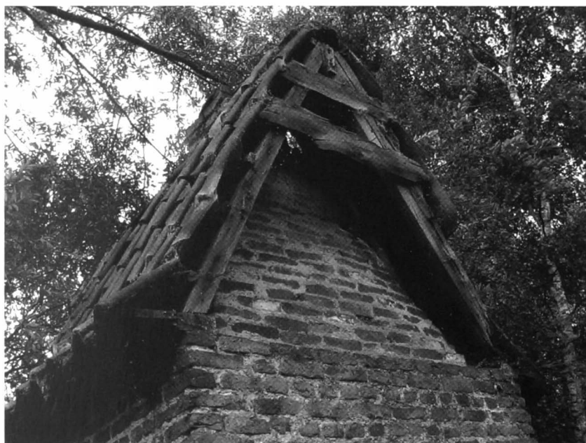
Afb. 3: Schouw en dakconstructie aan de achterzijde (foto Hugo Cuppens, september 2004)
