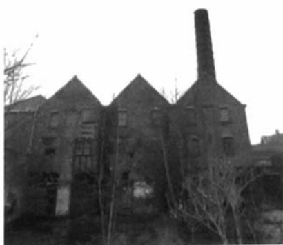
Detail van de achterkant.
