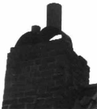
Schouwveursten Ver Elst-Dupont in de Veurnestraat te Poperinge op 1 februari 2006. Naast het gewoon exemplaar staat rechts een extra groot exemplaar met een stuk draineerbuis van grote diameter.
