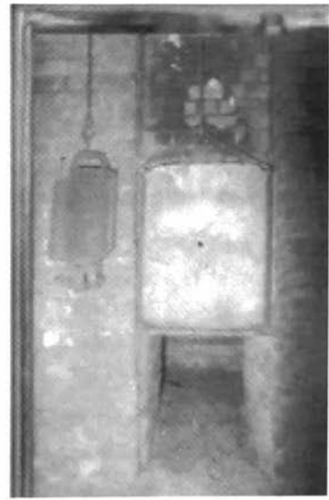
De opening om kolen in de oven te scheppen. Er werden 6 à 7 scheppen steenkool met de kolenschop ingeworpen. Voor de ovendeur was er een tegengewicht, een oude persvorm van gietijzer.
