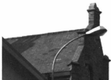
Dak met schalieveursten, Ieperstraat 145, Poperinge op 12 maart 2006.
