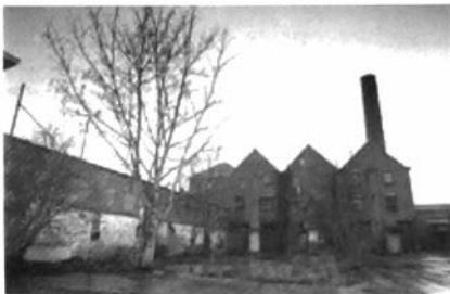
Achterkant, het fabricatiegebouw was reeds afgebroken.
