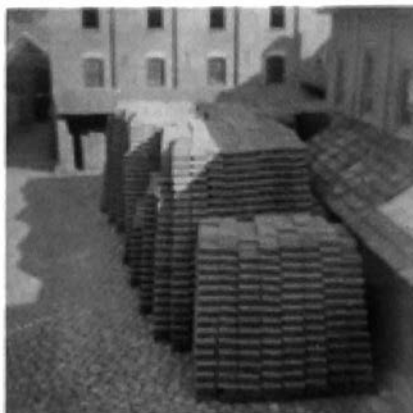
Stapels draineerbuizen in 1965
