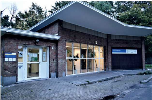
Figuur 2. Het huidige dispensarium in het Vogelenzangpark (Gent).
