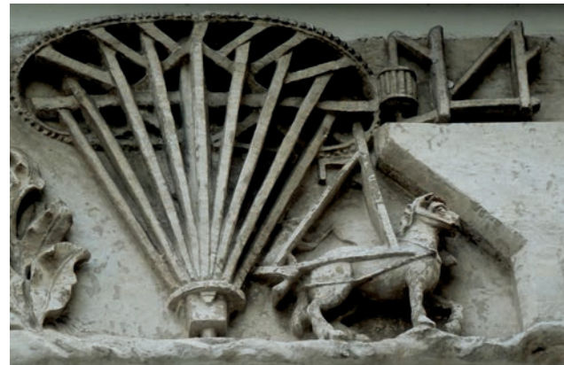
Figuur 5. Rosmolen afgebeeld op een van de gevelstenen van huis De Lelie in de Gentse Meersenijsstraat. In de vorige eeuw tot omstreeks 2000, werkte hier een kleine, elektrisch aangedreven maalderij.
