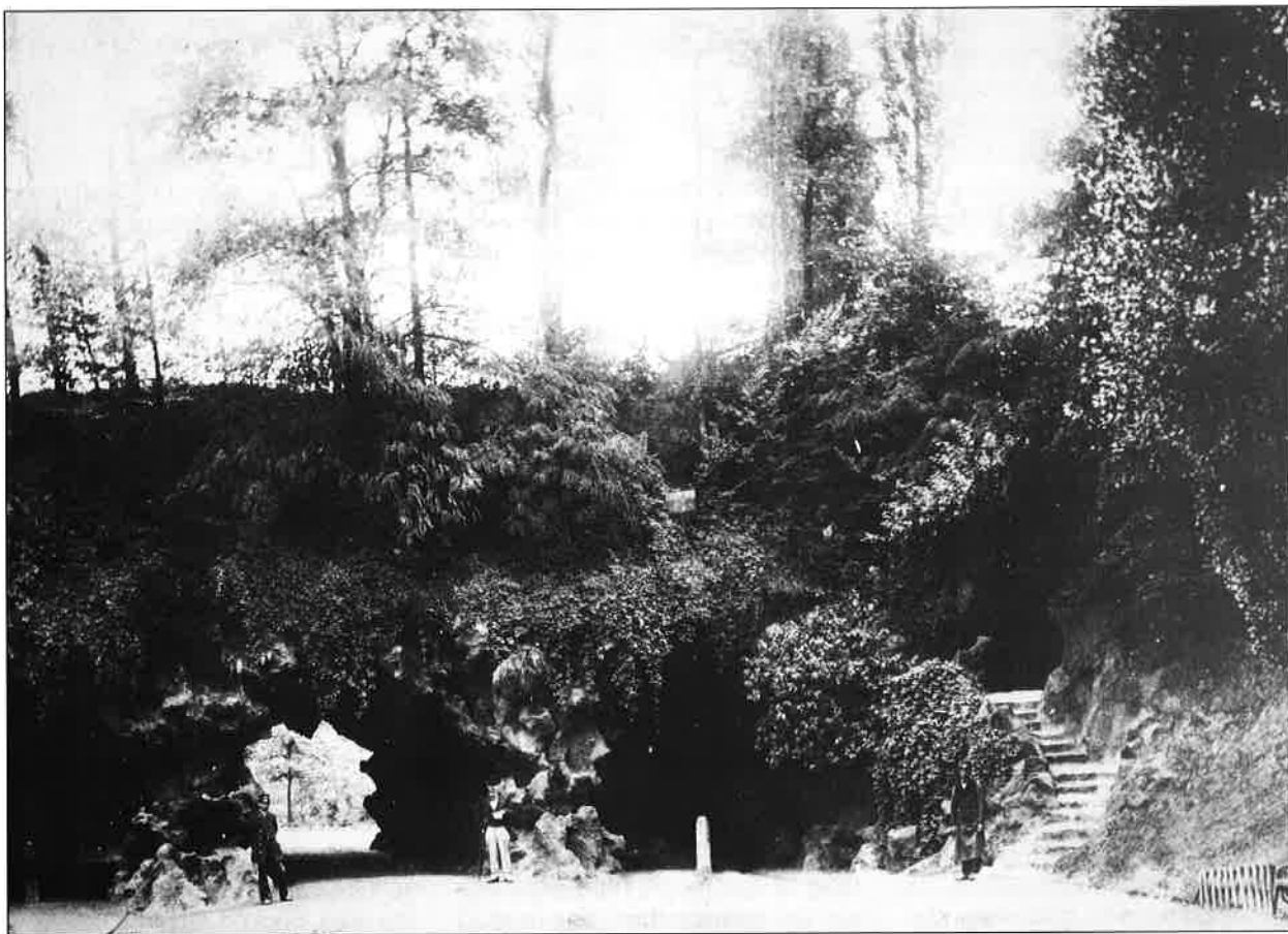
De tunnel van de zg. 'Zwitserse vallei' in het Gents Citadelpark, één van de vroegste toepassingen van gewapend cement 'rockwork' te Gent door de Brusselse 'roccailleur' Dumilieu (ca. 1885) (foto verzameling auteur)
