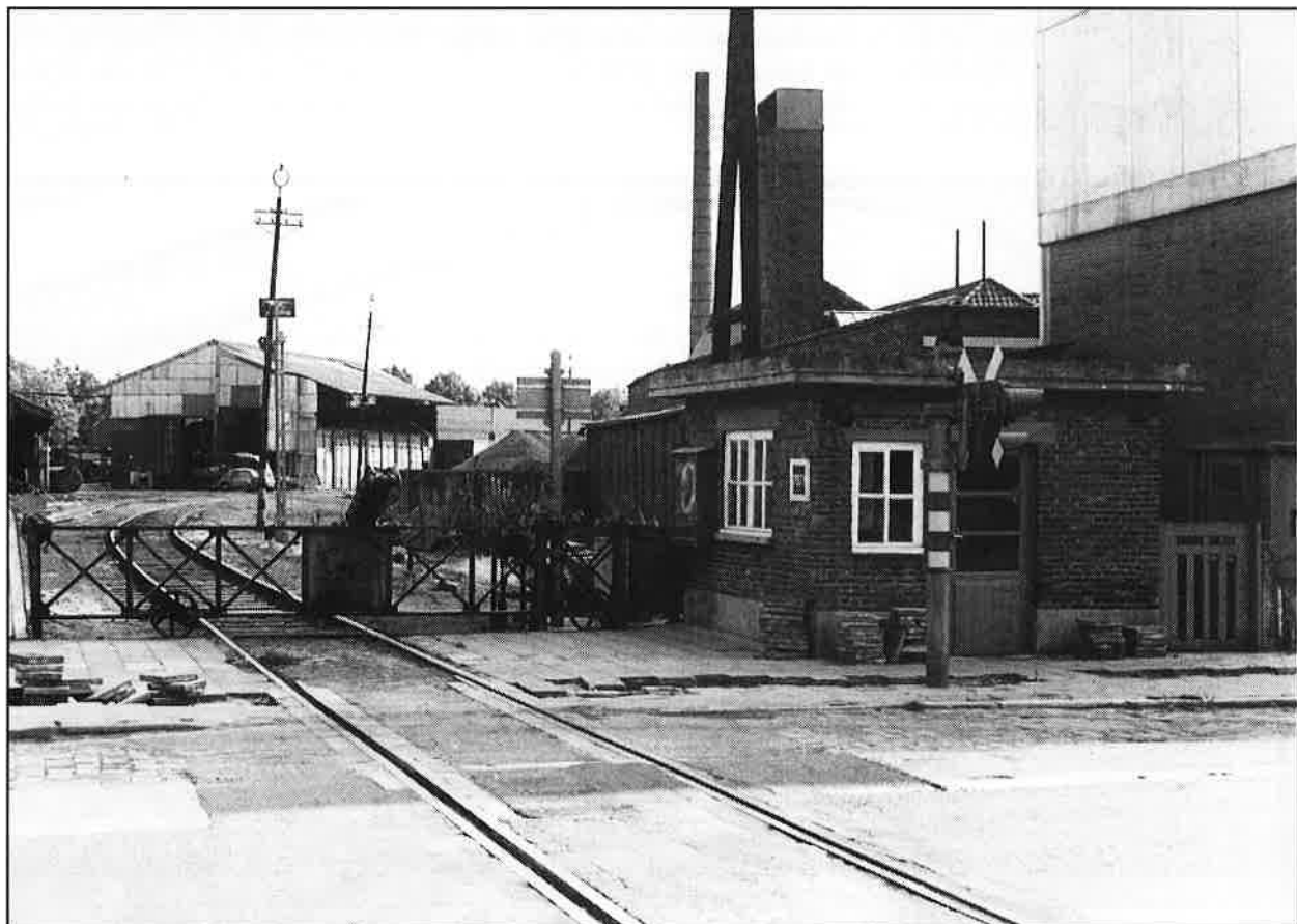
De (verdwenen) toegang tot de terreinen van het voormalig Rabotstation aan de Gasmeterlaan (cfr. rollende bareel ) (foto auteur, Gent 1980)
