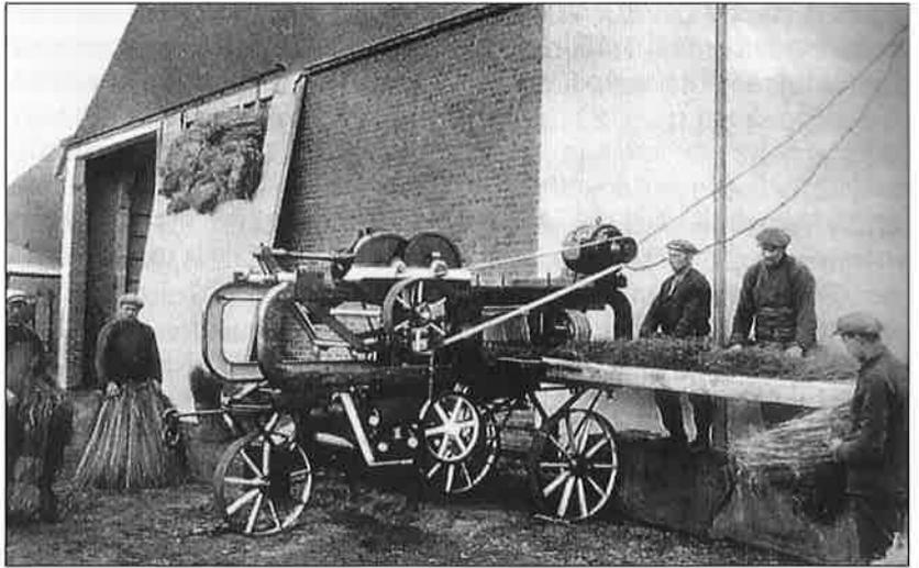
In het Interbellum werd het Vlaamse platteland met rasse schreden geëlektrificeerd. Kort na de eerste wereldoorlog gebruikte men bijvoorbeeld reeds bij het repelen van het vlas een machine aangedreven door een electromotor.
