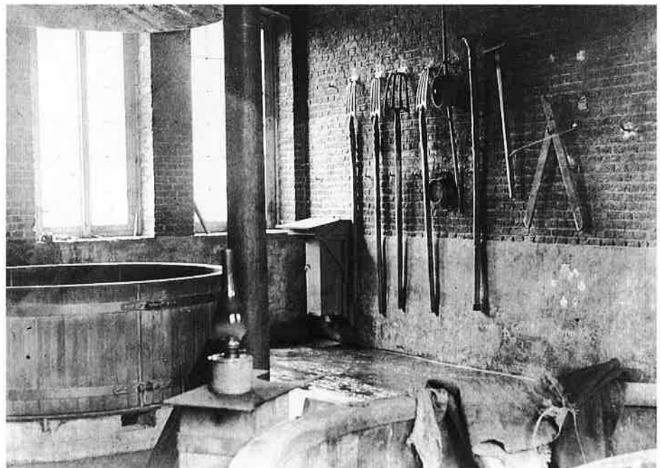
Interieur van de brouwerij Donny in de Sint-Pietersnieuwstraat, nog met houten met koper bekleedde roerketels, aan de muur roervorken (vóór 1896).
