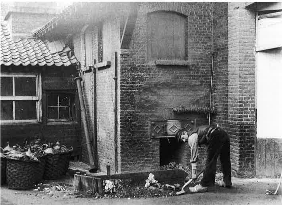
Stookinstallatie van de brouwerij Donny in de Sint-Pietersnieuwstraat: ketelhuis met vuurmond van buiten uit te vullen. Links op de achtergrond de voet van de vierkante schoorsteen.
