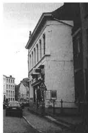
Overblijvend stuk borstwering van de Karnemelkbrug, Steendam (foto auteur)
