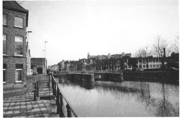
De sluis aan het Reke (foto auteur)
