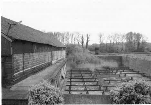
Zicht op de droog- dokken, de wanden werden opgebouwd uit baksteen en de bodem bestond uit aangestampte aarde met daarop houten planken
