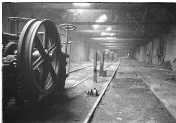
De oorspronkelijke toestand van de voormalige stoom-touwslagbaan van Le Lis te Hamme, minstens honderd jaar oud. Eén volledige lijninstallatie werd door het MIAT gered Verzameling MIAT, Gent. Foto Josiane Kisteman
