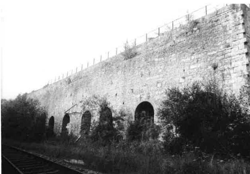
Batterij voormalige kalkovens voor afwisselend stoken, langs de spoorweg te Lienne-Ciney (foto Patrick Viaene, MIAT, 1986)
