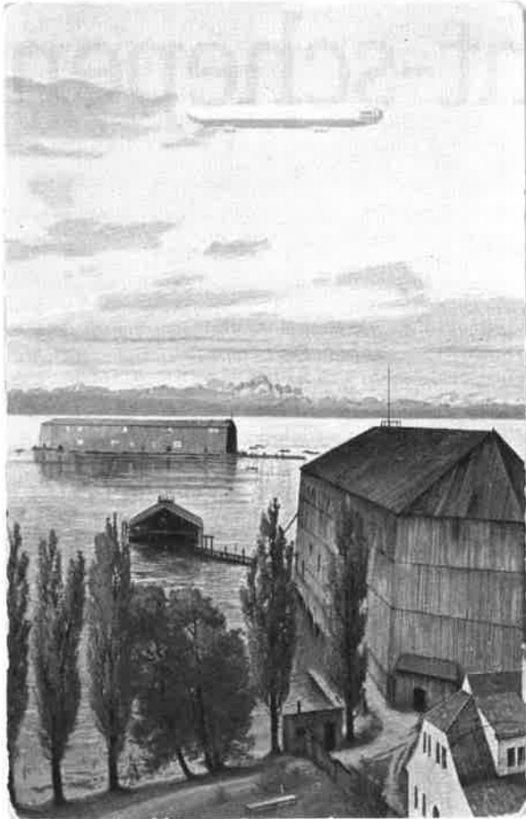
Zeppelinhallen waren van bij het begin staaltjes van ingenieurskunst, zoals de eerste drijvende hallen op de Bodensee anno 1900-1908 (linksboven en -onder), of de eerste hal op vaste bodem in de thuis-haven van de firma Zeppelin, Friedrichshafen (Zuid-Duitsland) uit 1909 (onder)
