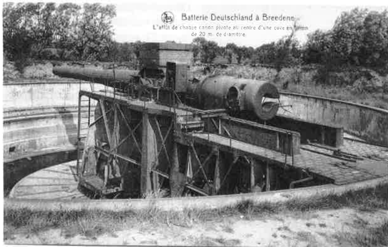
Affuit van het reuzenkanon van de batterij 'Deutschland' te Bredene, met weggenomen pantsering (links) en de batterij 'Pommern' te Koekelare-Leugenboom (rechts).
