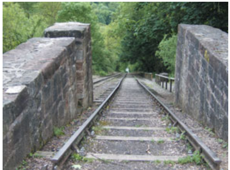
De 282 m lange 'Hay Inclined plane' die het hoogteverschil van 62 m overbrugt tussen het Shropshirekanaal en de rivier de Severn. Pieter Neirinckx
