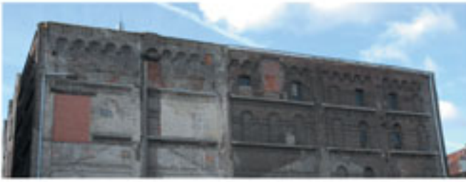
2 Stoommoutmakerij N.V. Van der Cruyssen - De Moor & Cie De graanmagazijnen, bestaande uit vijf bouwlagen met kleine getoogde openingen en zware verankering, domineren de Gillis Coppinssteeg.
