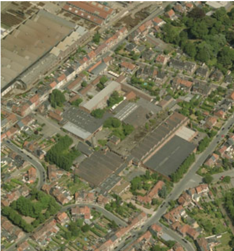
Luchtfoto van de site in 2008 voor de afbraak.
