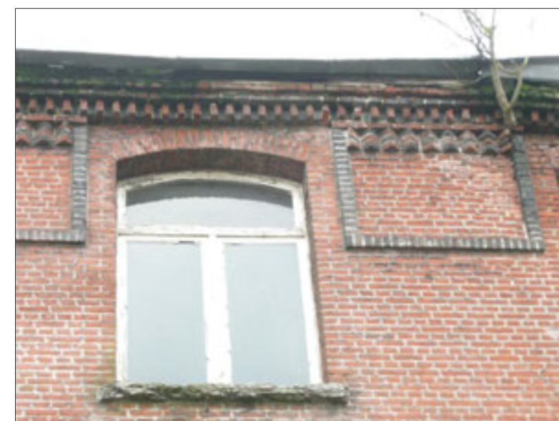
Boven: Het Kasteel van De Naeyer in 1910. BAW, P458 Midden: Oudste gekende afbeelding van de fabriek, te dateren tussen 1865 en 1883. BAW, GF 3450 Onder: Detail van het metselwerk van de directeurswoning. Foto 2009
