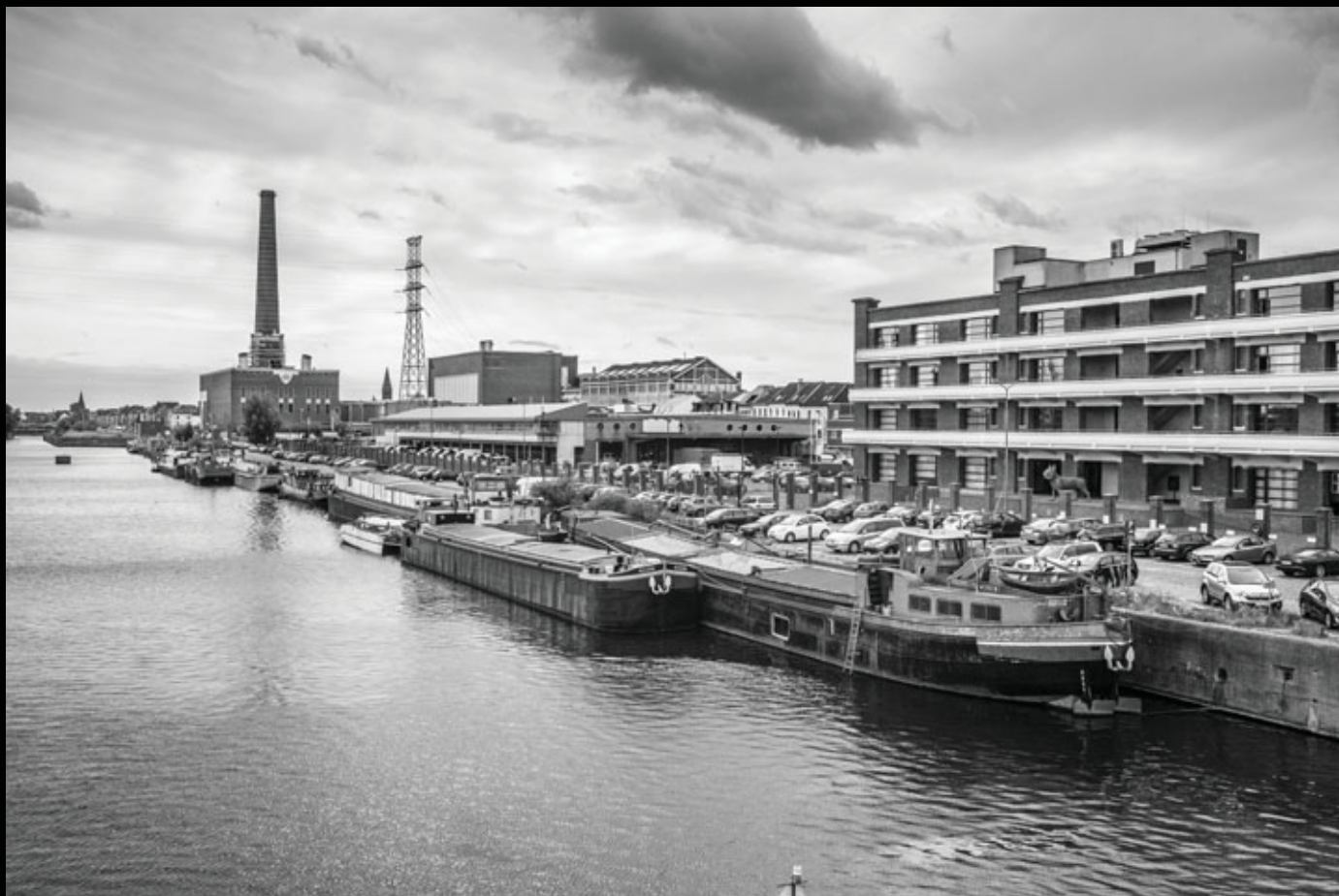
Boven: Dok Noord met het Handelsdokcenter © Christophe Vander Eecken
