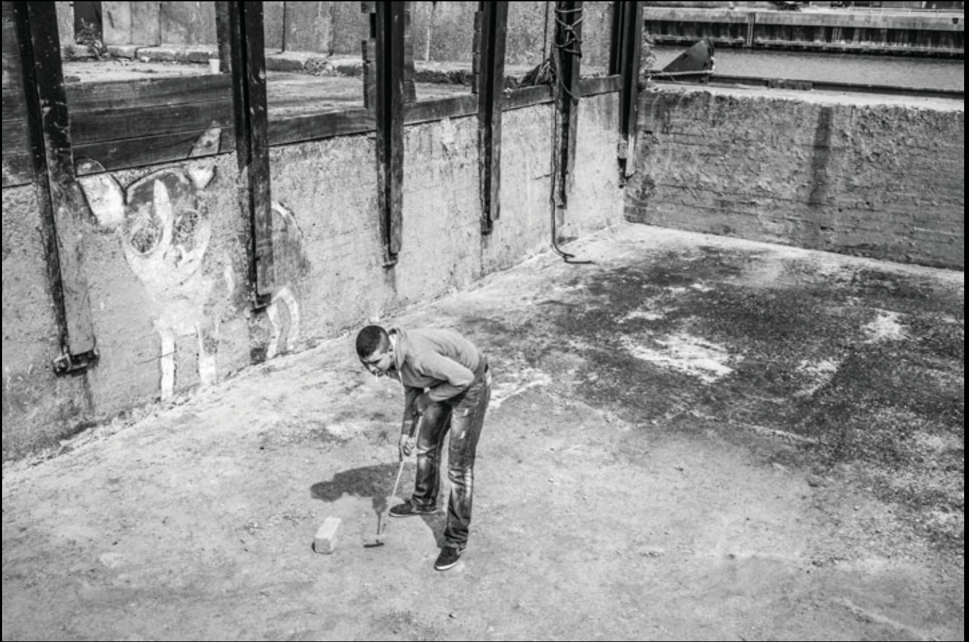
Boven: Grindbakken aan de blauwe kraan, voor renovatie © Christophe Vander Eecken
