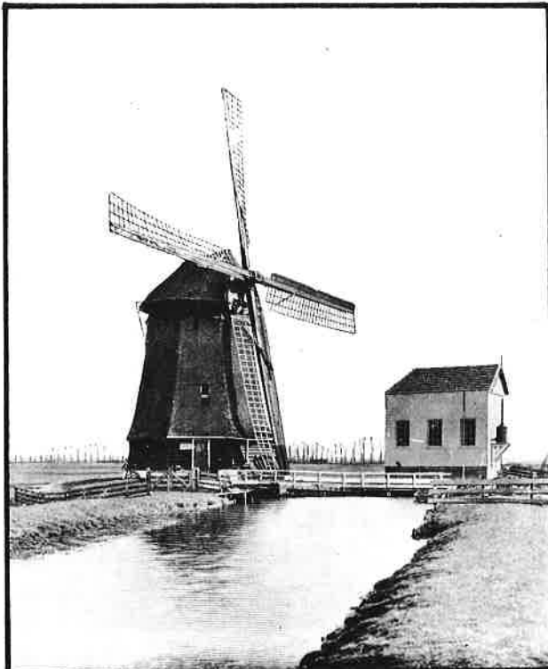
Oud en nieuw : bemaling d.m.v. wind- molen t.o.v. dieselpomp (ca 1913)
