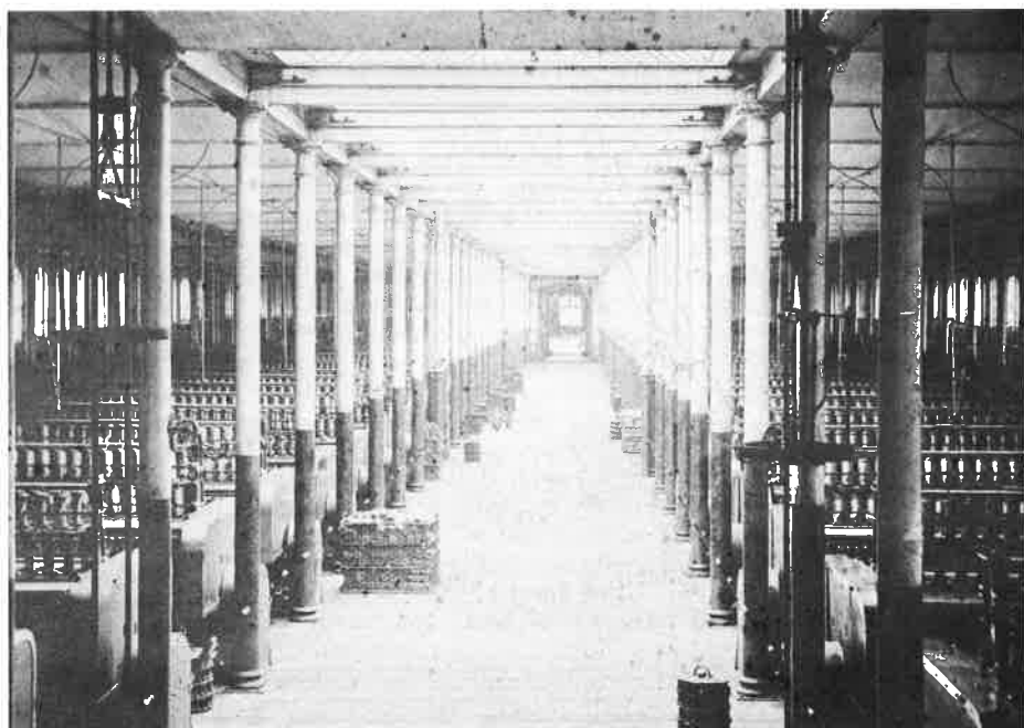
De vlasspinnerij vond te Gent huisvesting in hetzelfde type zg. Manchesteriaanse filatures à l'étage als de katoenijverheid : de fire-proof fabrieksgebouwen opgebouwd uit gietijzeren kolommen en bakstenen gewelven, ontwikkeld in Engeland. (Foto verzameling MIAT)
