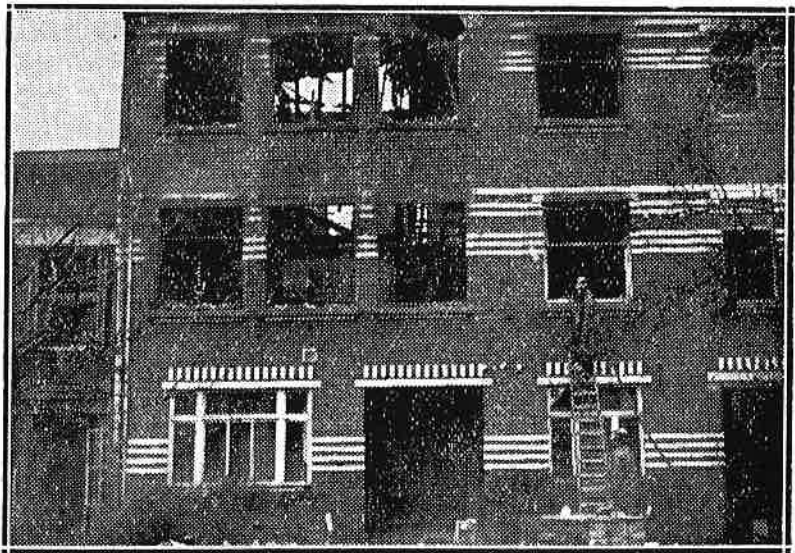
Het puin der uitgebrande usine « Optic ».
