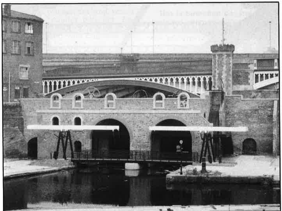
Het gedeeltelijk gereconstrueerde pakhuis van Grocer's Company op het einde van het Bridgewater Canal . (foto auteur)
