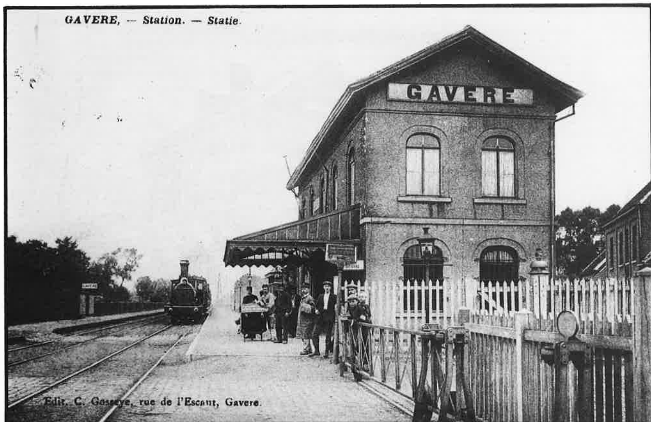
Een zeldzaam-gave afbeelding van de vroegere schuifhekkens aan de overwegen, gietijzeren waarschuwbord, dito lantaarnpaal en alarmbel inclus
