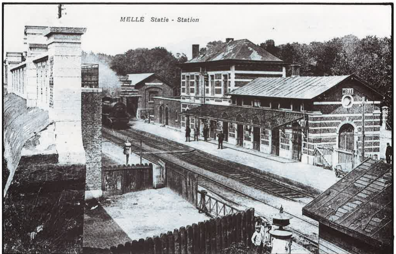
Het oude station van Melle gezien vanop de later aangelegde verhoogde spoorwegberm
