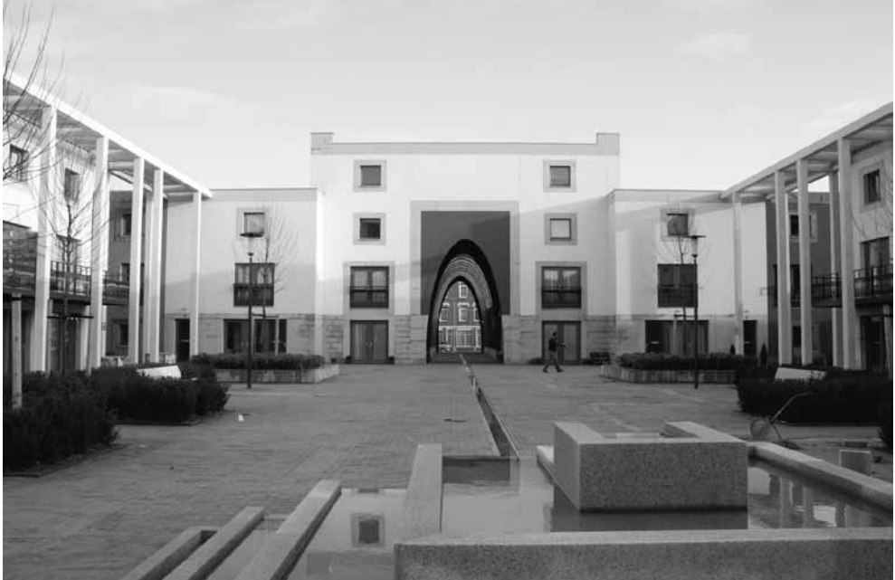
Binnenplein. Foto: Geurst en Schulze architecten
