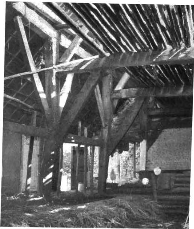
Abb. 4. Ständerreihe mit durchgezapften Ankerbalken
