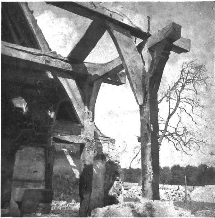
Abb. 1. Kübbungsseite eines nordmünsterländischen Dreiständerhauses von 1629 im Abbruch.
