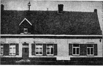
Woonhuis « Het Vlaagt ». Verbouwingen hebben de rondbouw van de vensters doen verdwijnen.
