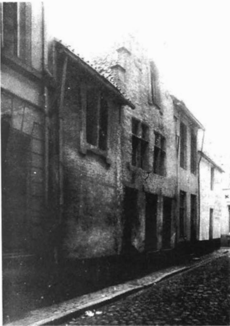
Afb. 2. — De Kromme Stege gezien naar de Bennestege toe; toestand vóór de rechttrekking (1897-1898).
