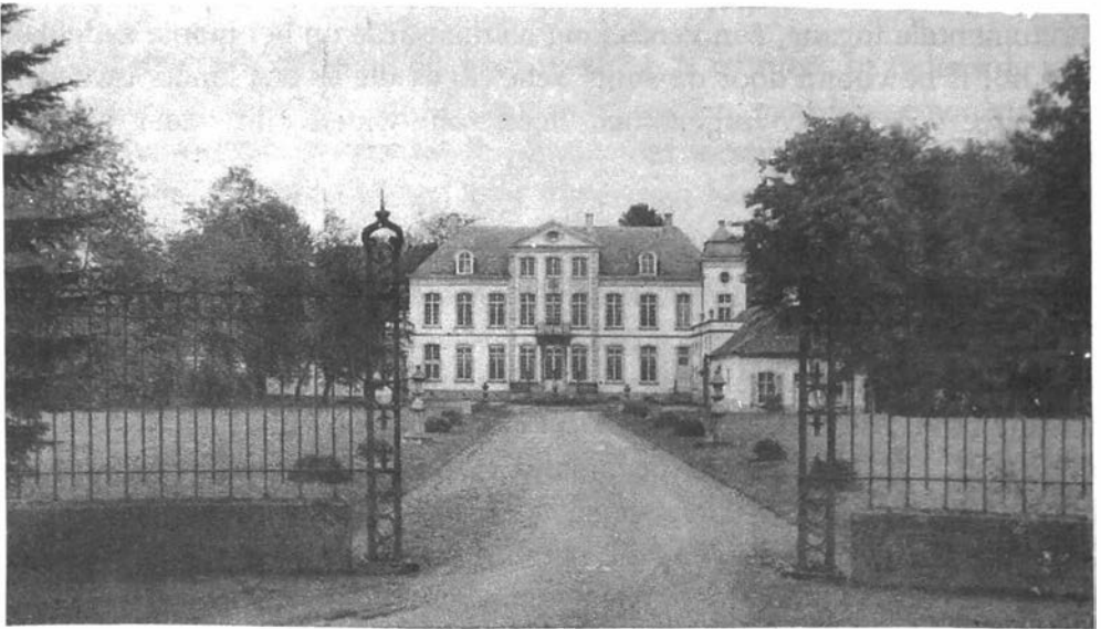
Massemen : Het Geuzenkasteel
