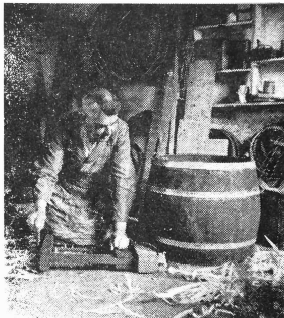
Afb. 7 : Het samendraaien van de duigen met de spanvijs.
