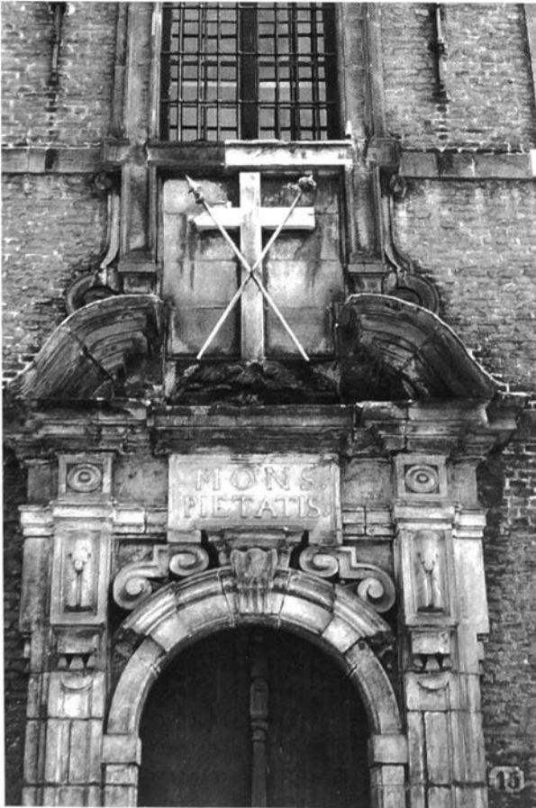
De "Arma Christi" boven de toegangsdeur
