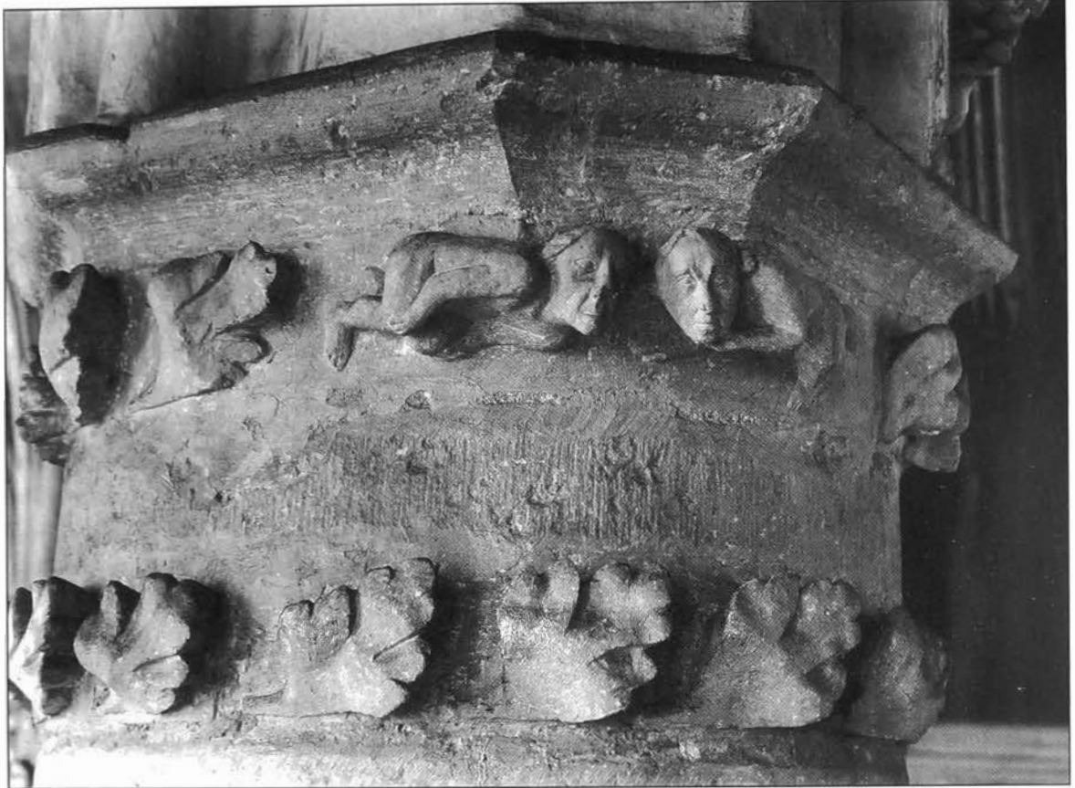
Kapiteel in het schip van de begijnhofkerk te Leuven (eerste helft 14de eeuw). Tengevolge van de beperkte afmetingen van de natuurlijke blokken Gobertangestein diende het kapiteel te worden opgebouwd uit vijf lagen en is het beeldhouwwerk niet hoger dan ongeveer 15 cm. Daarom ook werden de menselijke figuren horizontaal voorgesteld en moest men twee rijen bladmotieven sculpteren om het kapiteel te vullen. Dit is het oudste voorbeeld van een kapiteel dat zou uitgroeien tot het bekende zgn. Brabants-gotische kapiteel met twee rijen koolbladeren (Copyright IRPA-KIK, Brussel).
