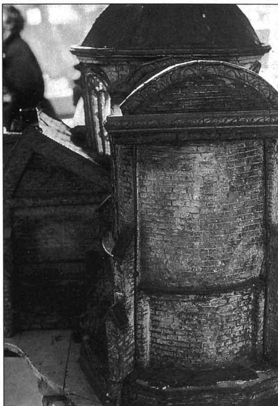
(afb. 6) Oostzijde met achterkant van het koor (eigen foto).
