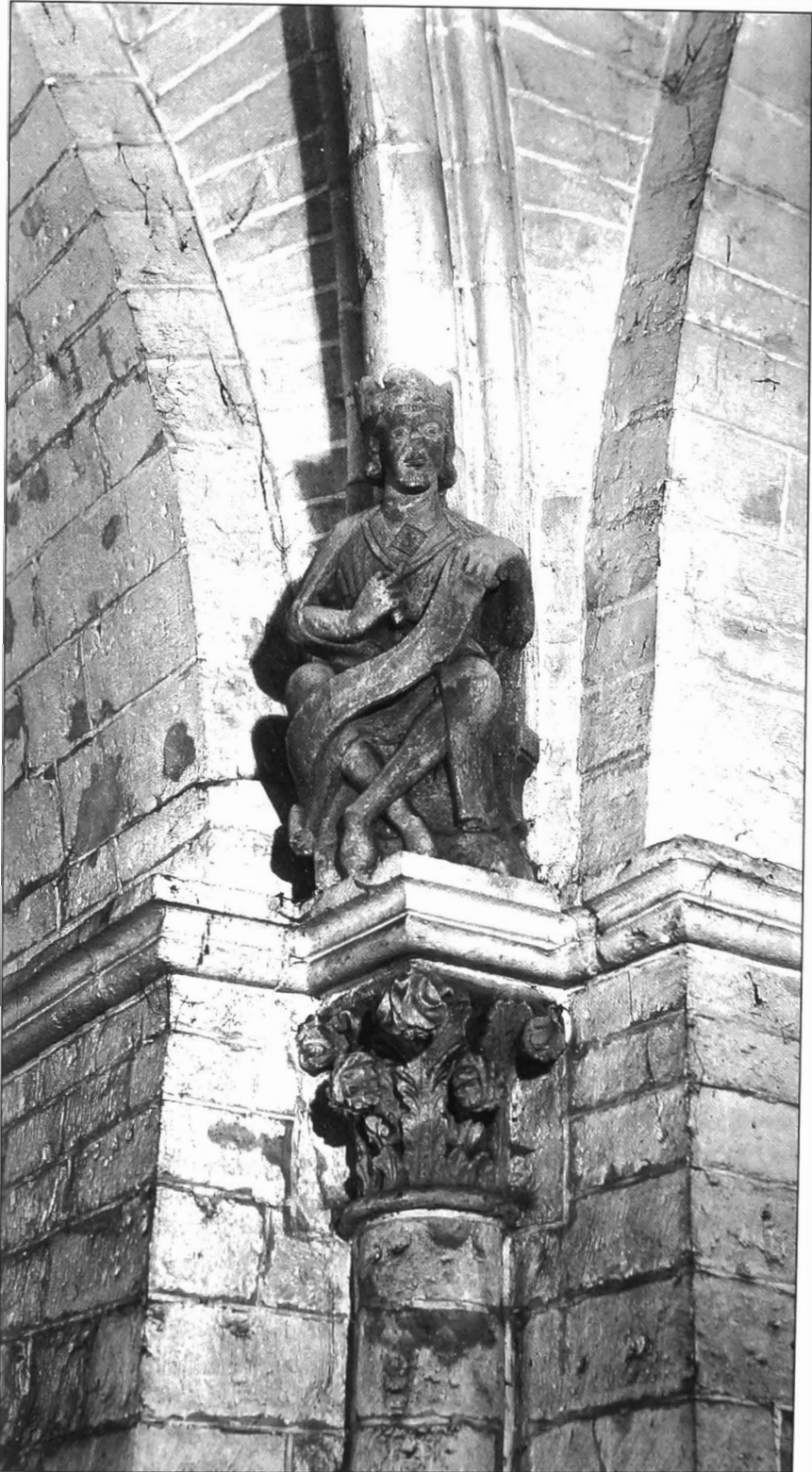
Kapiteel en beeldhouwwerk in de middentravee van de westbouw van de Sint-Germanuskerk te Tienen (tweede kwart 13de eeuw). Grote beeldhouwwerken kon men moeilijk realiseren in de kleine blokken Gobertangesteen. Daarom was men in bepaalde gevallen genoodzaakt om over te schakelen op andere steensoorten zoals hier de Naamse steen (?) (Copyright IRPA-KIK, Brussel).
