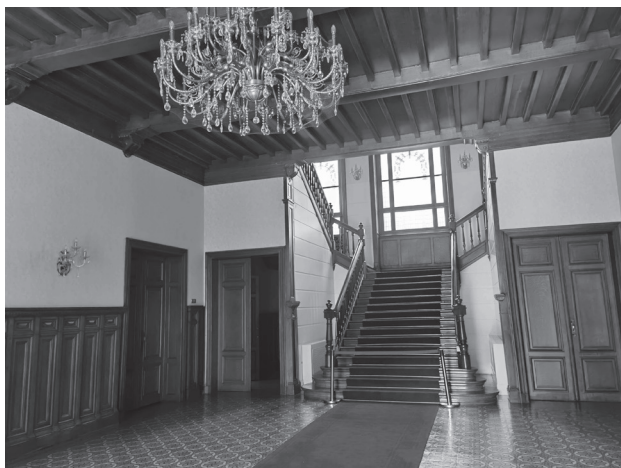
Afbeelding 15: Lambrisering in eikenhout uitgevoerd door het Belgische bedrijf De Waele.
