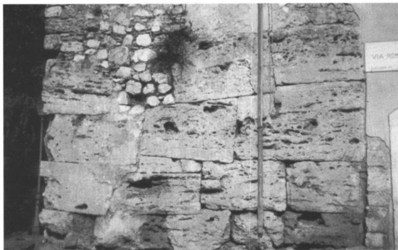
Fig. iv: Muurfragment van de stadsomwalling in polygonaal muurverband aan de Largo Cappuccini; zuid-oostzijde (foto: I. Uytterhoeven)
