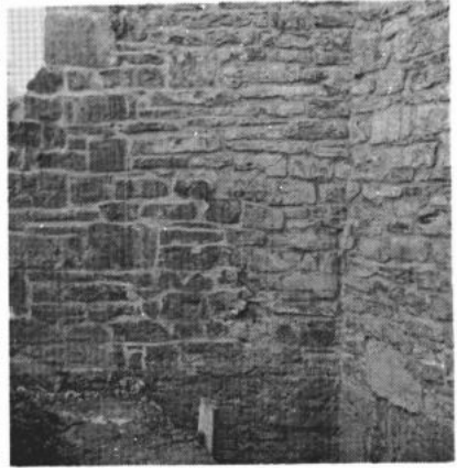
Afb. 23 — Centrale steunbeer van de O.L.V.-kapel - detail metselwerk
