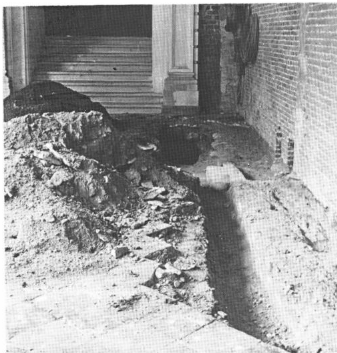
Afb. 14 — Noordwand: romaanse fundering en toegang tot de lichthof van de verdwenen kerk
