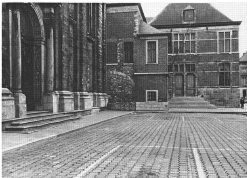
Afb. 8 — Toegemuurde ingang tot de lichthof van de kerk
